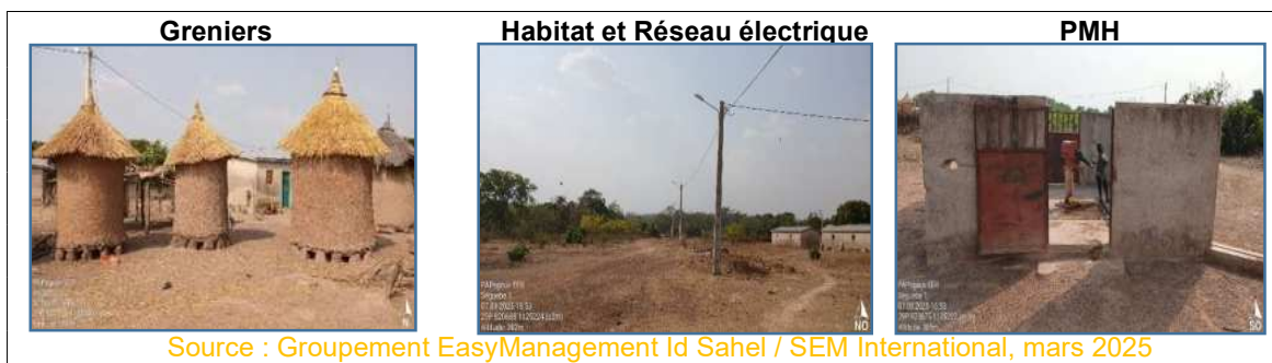
Planche 9 : Vue de quelques ouvrages à Kassiole
